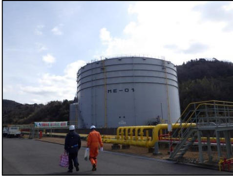
特定屋外タンク貯蔵所
