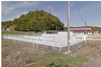
解体前のプール
