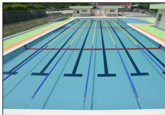
豊栄小学校プール完成写真
