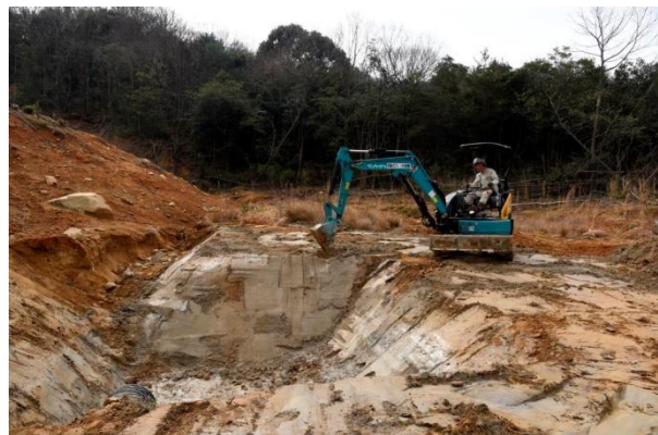
史跡鏡山城跡災害復旧工事
