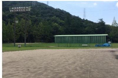
解体した照明と屋内練習場
