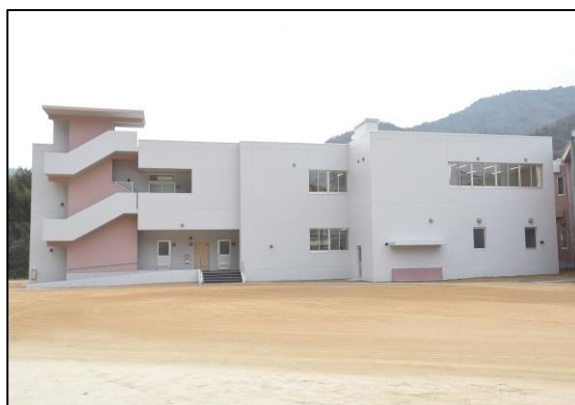
河内小中学校校舎完成写真
