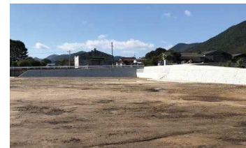
志和小中学校造成工事の様子
