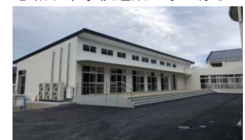
福富小中学校校舎工事の様子
