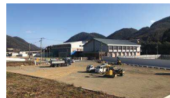
河内小中学校造成工事の様子
