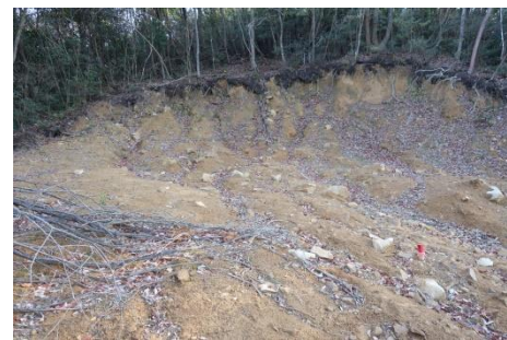
史跡鏡山城跡土砂崩れ箇所近景
