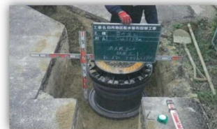
【消火栓工事(参考)】
