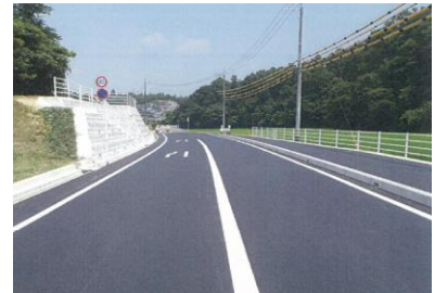
(整備中の幹線道路)
