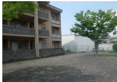
市営鍛冶屋団地及び浄水施設(外観)
