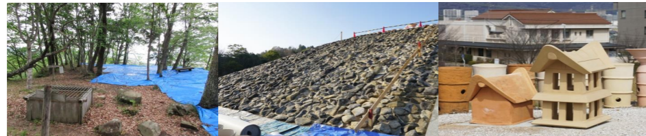
史跡鏡山城跡遺構保護シート敷設 史跡三ツ城古墳の保存修理(墳丘葺石修繕・形象埴輪交換)
