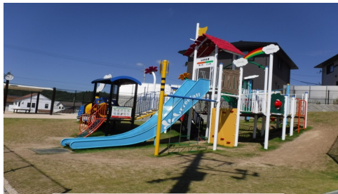
完成した寺家駅前3号公園の現況写真
