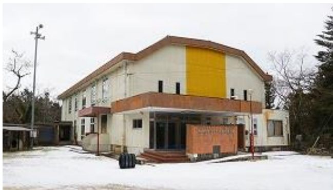
宇山地域センター大ホール（体育館）
