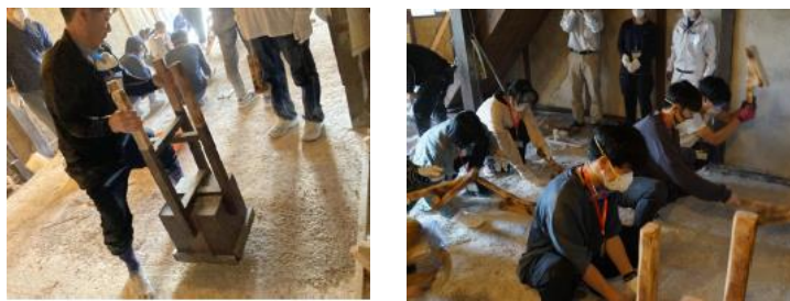
学生参加による改修の様子
