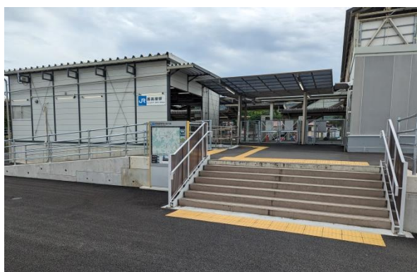
(仮駅舎の供用)
