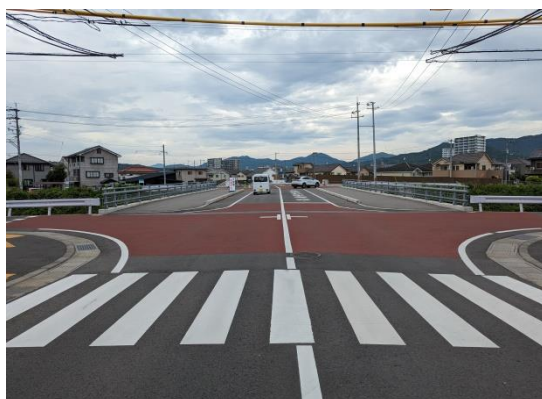
(江熊新橋の供用)
