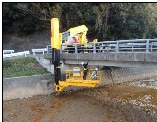
農道橋梁点検業務
