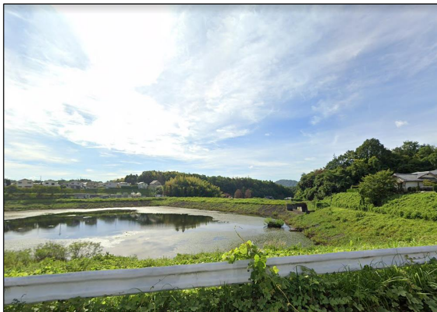
胡麻谷防災調節池
