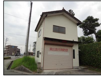
西条北方面隊下見分団格納庫
