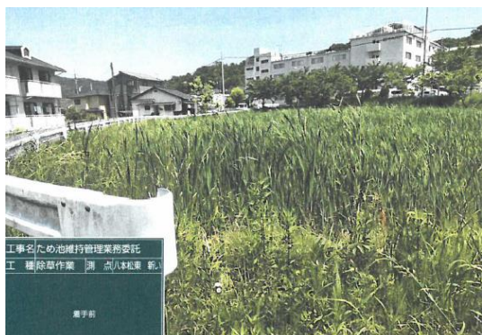
ため池除草前
