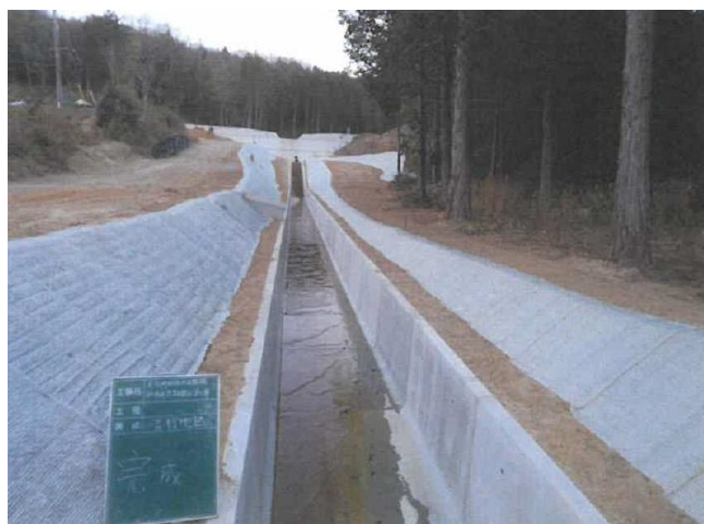
堰堤下流水路 小谷地区(高屋町)
