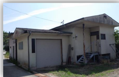
安芸津方面隊早田原南分団格納庫
