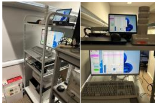
【タブレット、パソコン、プリンター、指令室内に設置】
