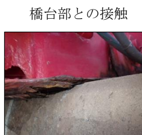
支承部の沈下
