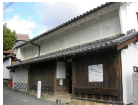
重要文化財 旧木原家住宅
