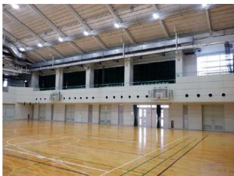
屋内運動場空調設備
