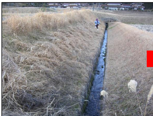
センチピードグラス施工前
