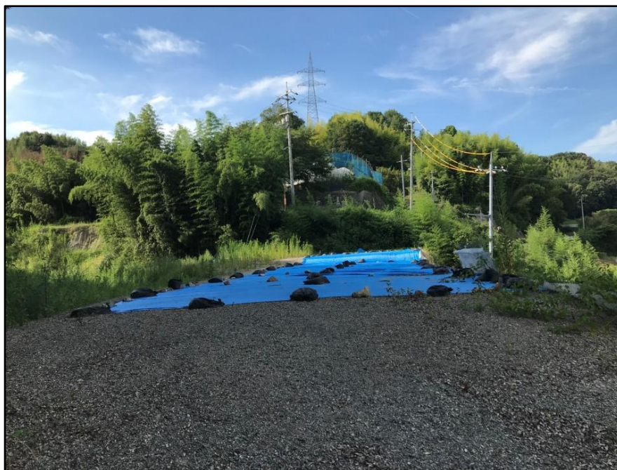
赤崎農道 (改良工事)
