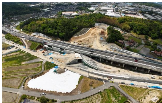
正力飯田線及びランプ予定地付近 R8.5 撮影
