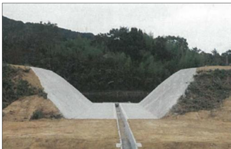
工事後の廃止ため池
