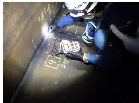
【保安検査（溶接部検査）の様子】
