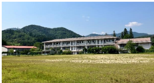
福富みらいベースに改修予定の旧竹仁小学校
