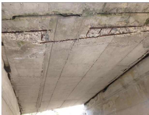
造賀 31 号線 1 号農道橋 (橋梁補修工事)
