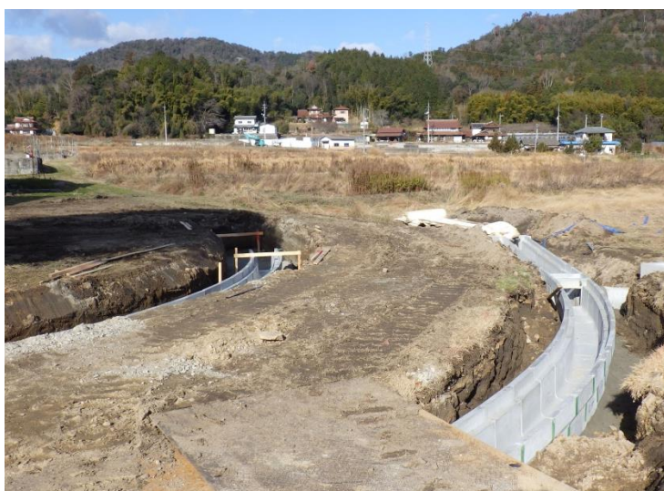
奥屋農道 (改良工事)
