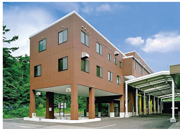
賀茂環境センター
