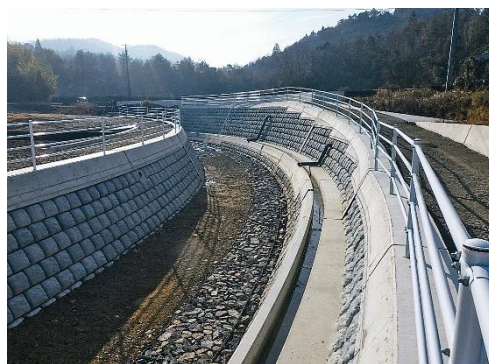
河川護岸整備
