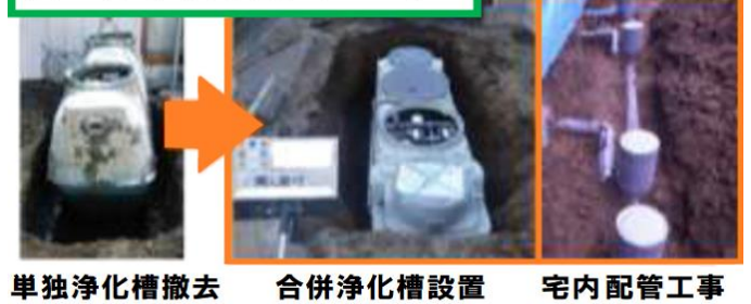
例：単独転換浄化槽設置工事
