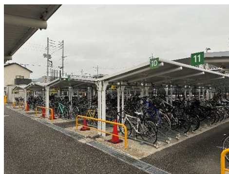
図 寺家駅南自転車駐車場
