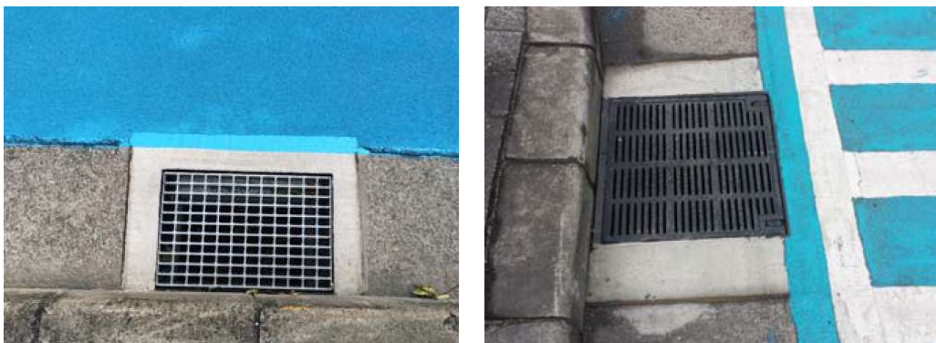
図 街渠をエプロン幅の狭い平坦性の高いものに置き換えた事例
