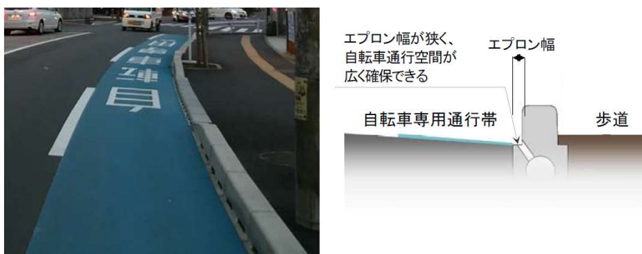
図 街渠をエプロン幅の狭い平坦性の高いものに置き換えた事例
