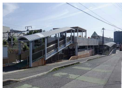
図 西条駅前第1自転車駐車場
