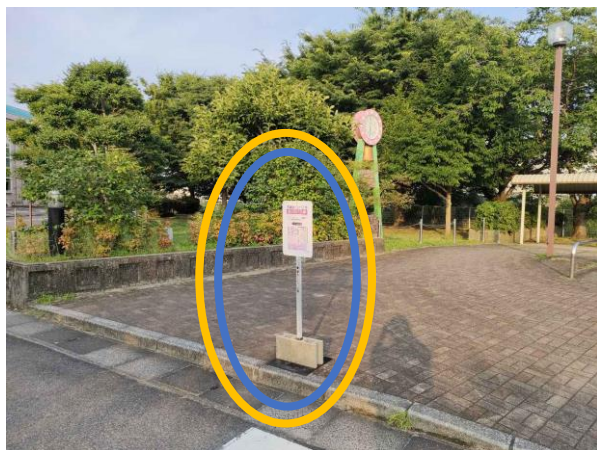
▽移設後バス停位置②（工事中・工事終了後）
