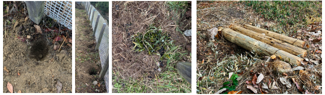
園地全体の土中環境を改善する「点穴」整備
