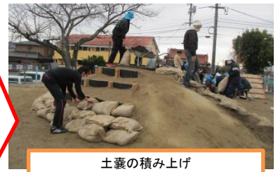
土嚢の積み上げ
