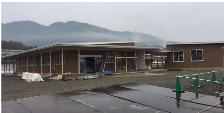
写真：建築中のみそのうにじいろ保育園
