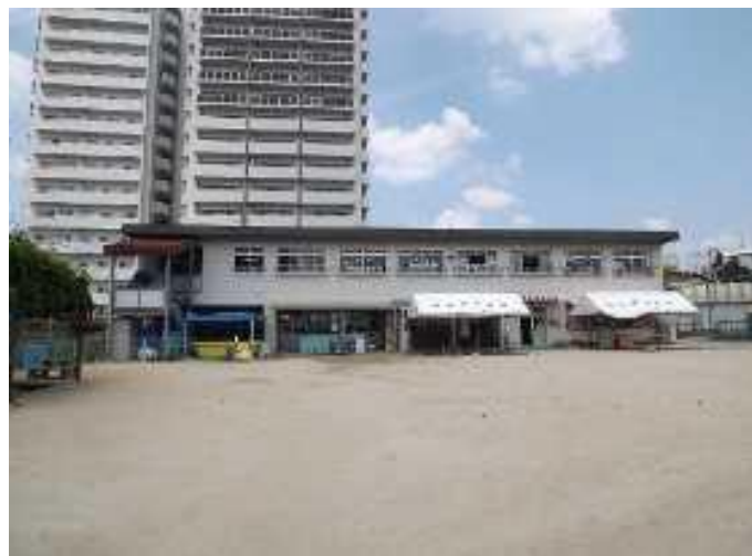
写真：老朽化対策のため建替えとなる西条東保育所
