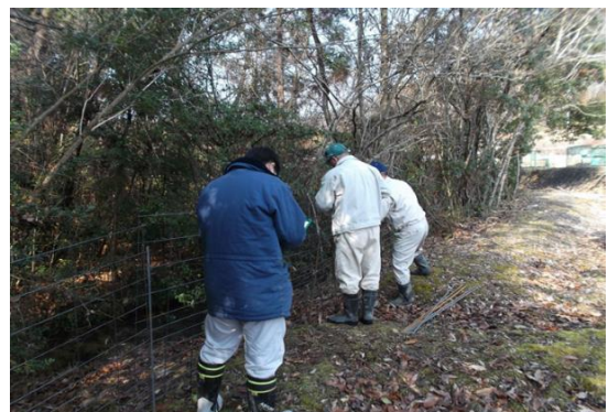
【防護柵の設置】
