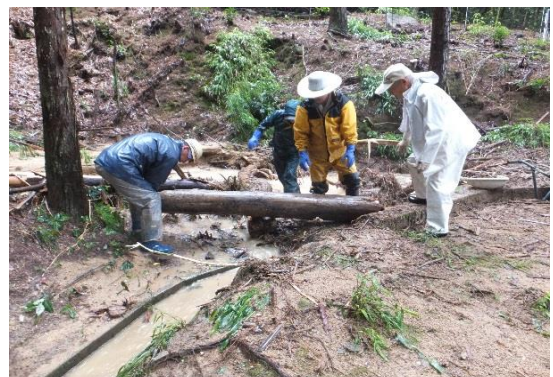
【協働作業による農業用施設の復旧】
