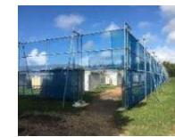
防風ネットの設置
