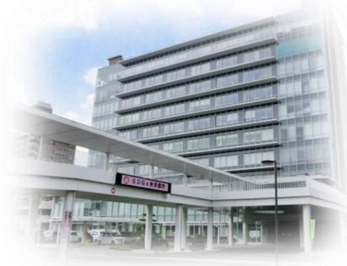
東広島市役所本館
