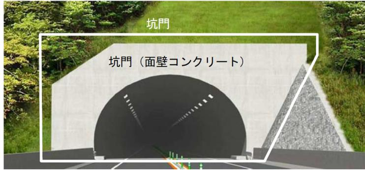
図 定期点検対象箇所例 (トンネル坑口部) ※道路トンネル定期点検要領
