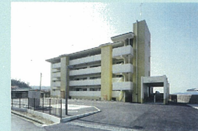
公営住宅等整備事業(市営砂原湯盛住宅16戸)
