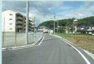
道路改良事業(市道湯盛宮ノ浦線)
