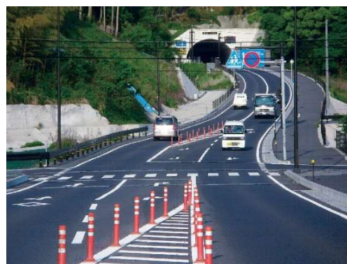
図 国道 185 号安芸津バイパス
