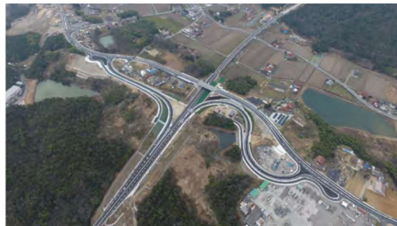
図 大多田インターチェンジ
