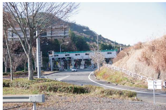
図 志和インターチェンジ
