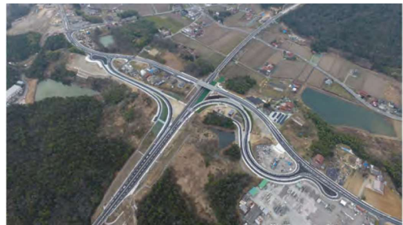
図 大多田インターチェンジ
