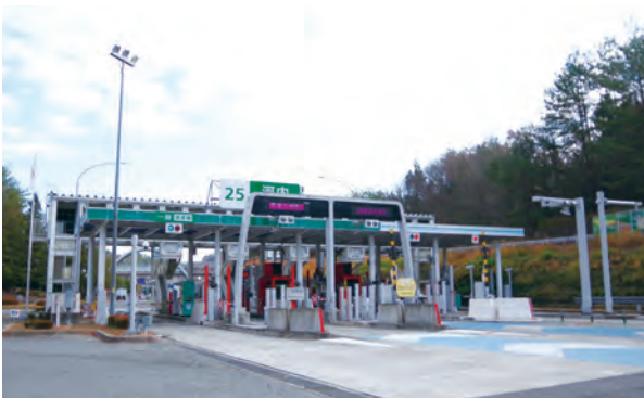
河内インターチェンジ
