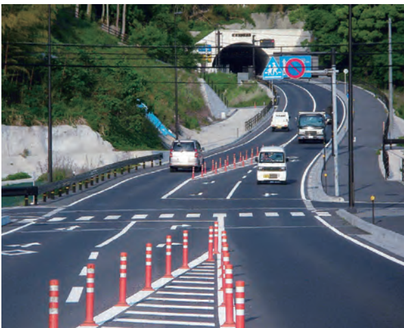
国道185号安芸津バイパス
