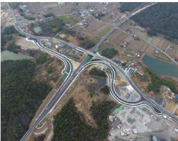
大多田インターチェンジ
