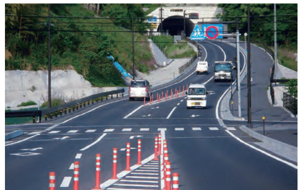
国道185号安芸津バイパス
