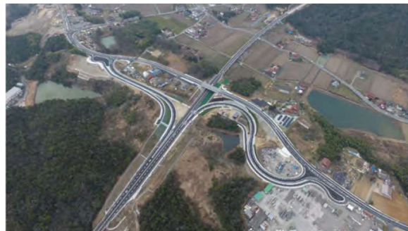
図 大多田インターチェンジ
