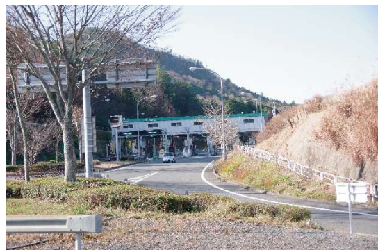
図 志和インターチェンジ
