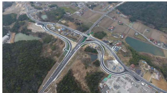
図 大多田インターチェンジ
