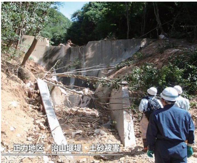
八本松西地区 市道宗吉政光線 道路崩落
