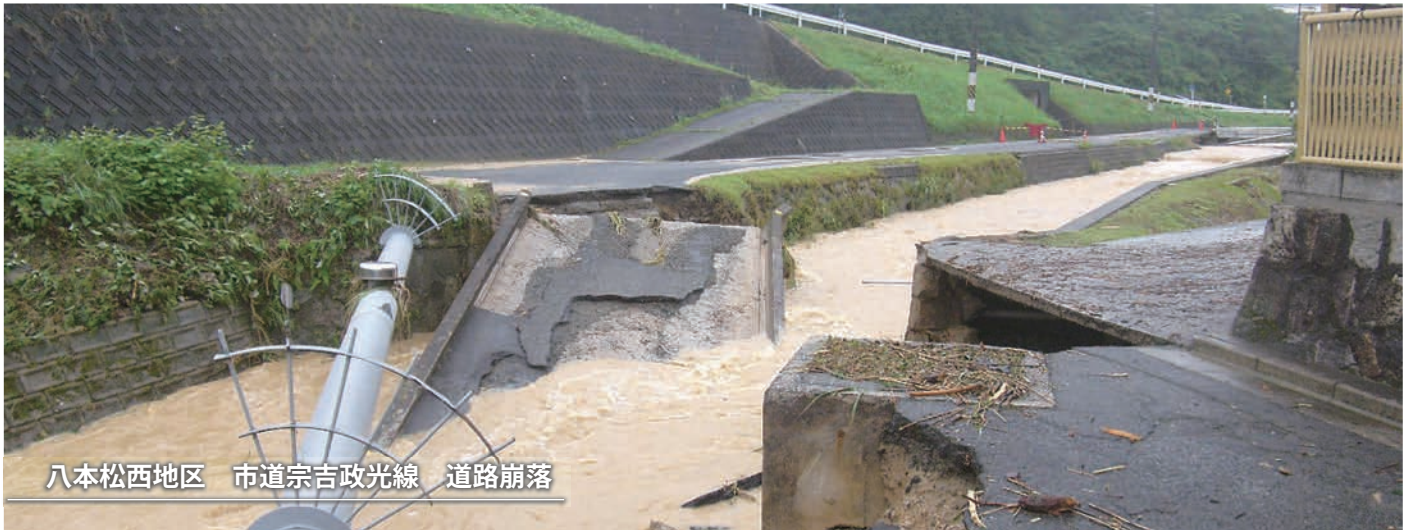
八本松西地区 土石流による土砂流入
