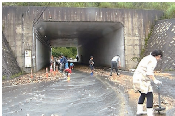
土砂撤去作業（八本松町）
