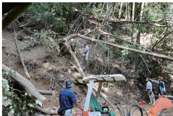
孤立集落へ向かうための道路啓開作業（河内町）
