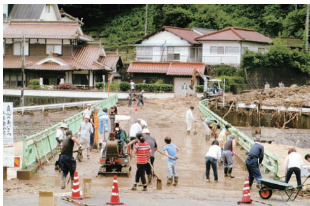
土砂撤去作業（河内町）
