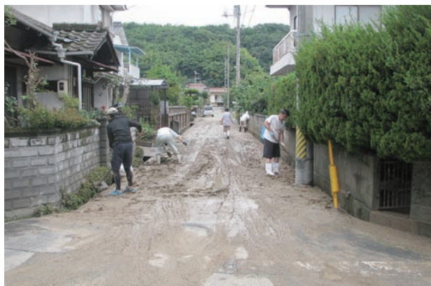
土砂撤去作業（安芸津町）
