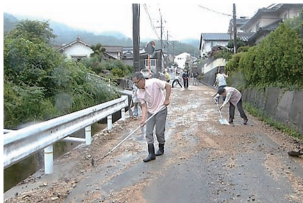
土砂撤去作業（八本松町）
