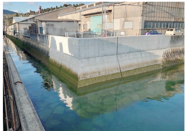
安芸津町 榊山護岸 (工事完了)
