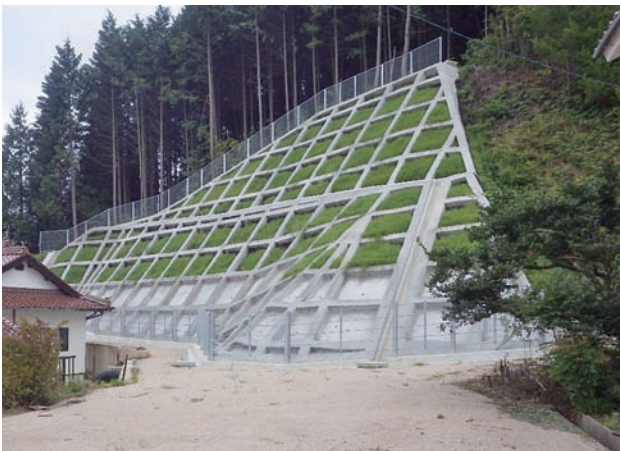
高屋町 小竹4地区 (工事完了)
