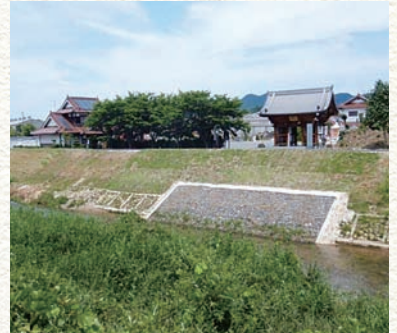
二級河川黒瀬川水系 黒瀬川 河川災害復旧工事 (西条町御菌宇 勝谷橋上)
