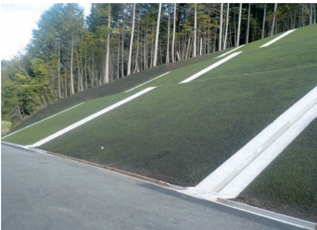
福富町 松崎学校線 (工事完了)
