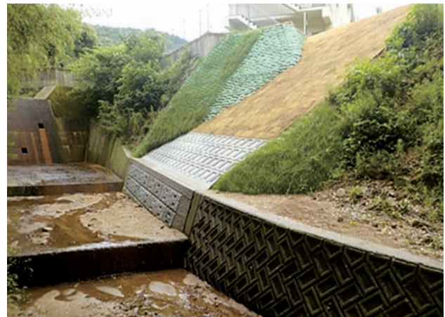
黒瀬町 桧谷川護岸 (工事完了)
