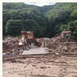
奥条川 災害関連緊急砂防事業 (河内町中河内)
