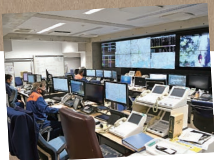
高機能消防指令センター
