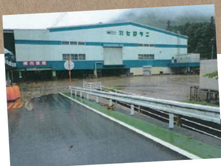
工場1Fに河川水が侵入
