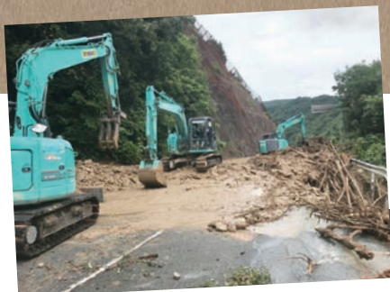
安芸津下三永線での復旧工事
