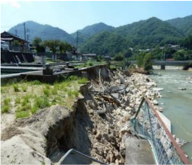
河内町 中河内地区（沼田川）
