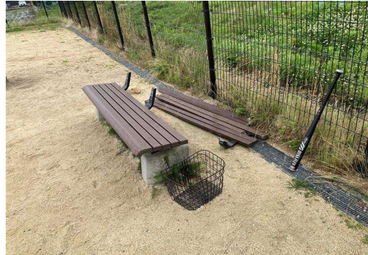
ベンチの破損
