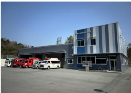
東広島消防署 高屋分署
