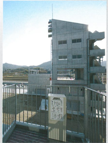
見学デッキから見た訓練棟
