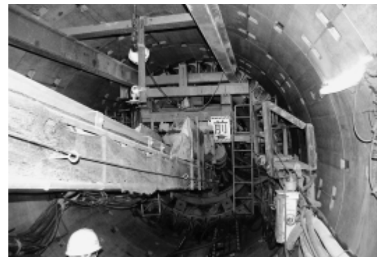
地中を掘り進む掘削機械
